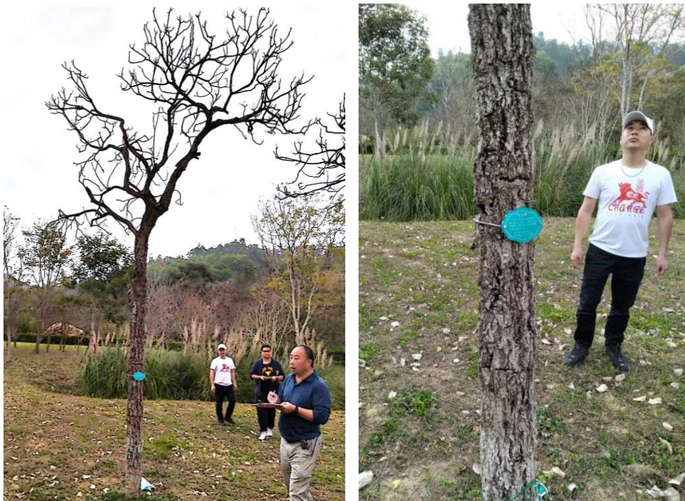
淘金山绿道枯树现场枯树图
