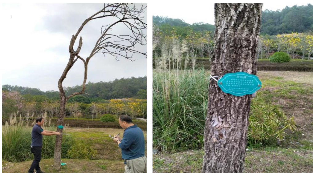
淘金山绿道枯树现场枯树图
