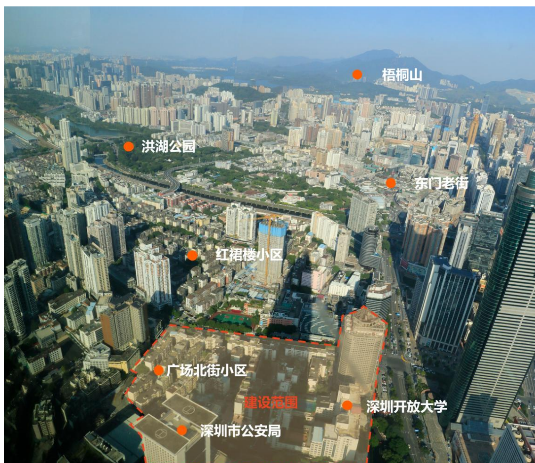
图 3-3 京基一百大厦顶层俯瞰区域图
