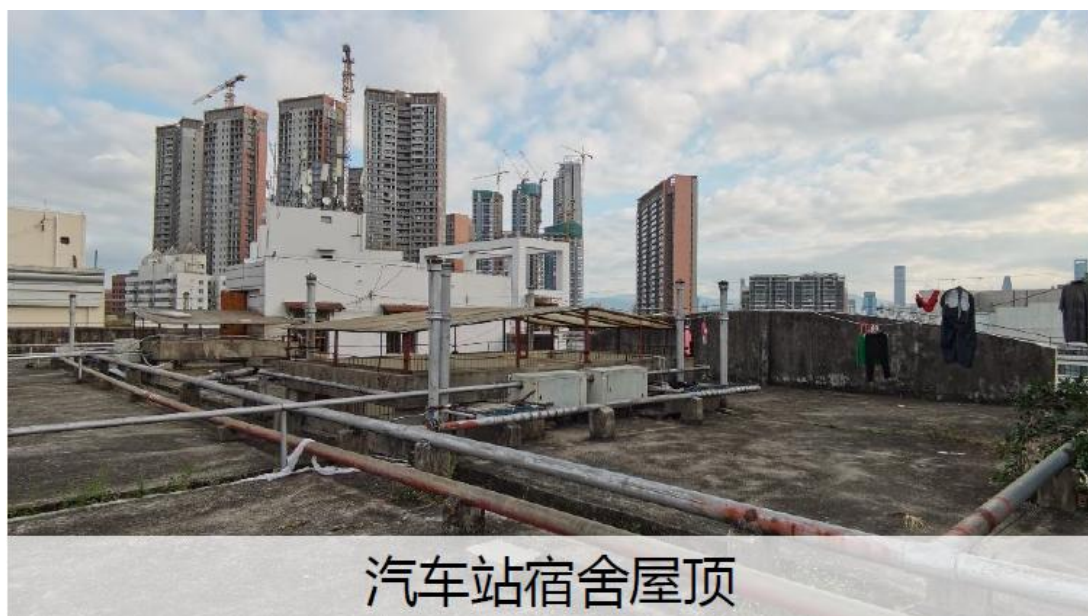
图 3-8 银湖汽车站屋顶现状图
