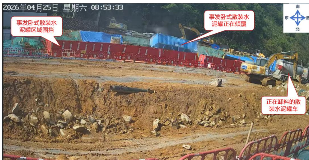
图 6 事发卧式散装水泥罐倾倒视频截图
