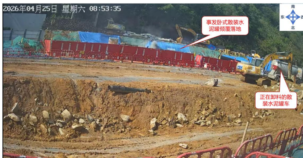
图 7 事发卧式散装水泥罐倾倒后状况视频截图
