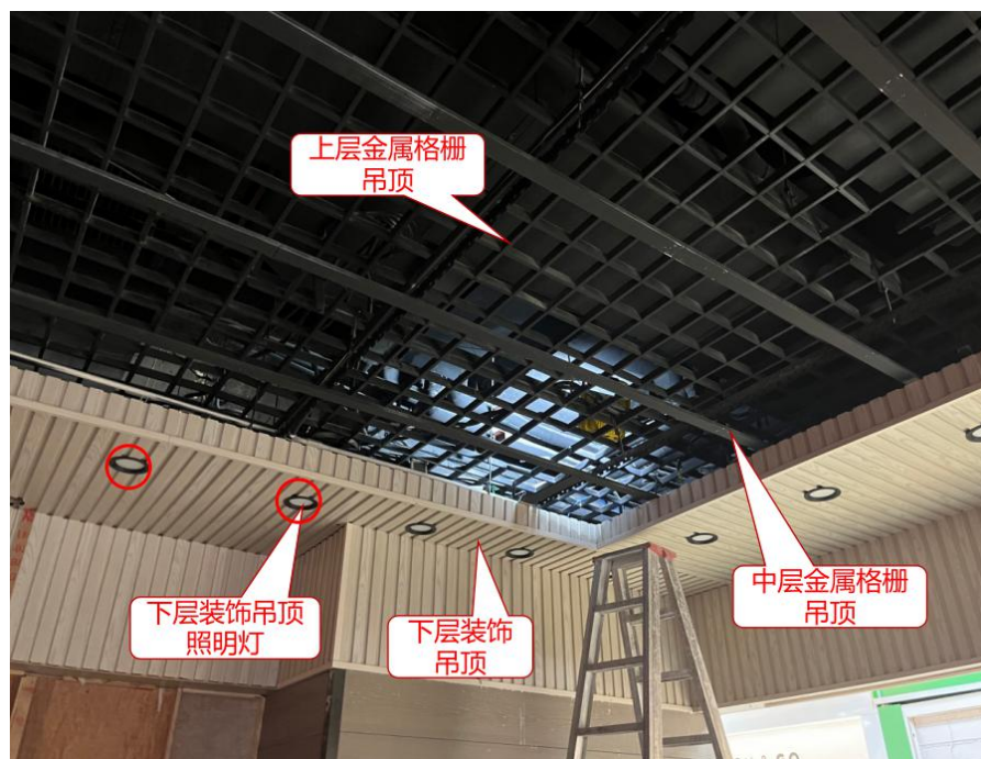
图 14 装饰吊顶照明灯勘查图
