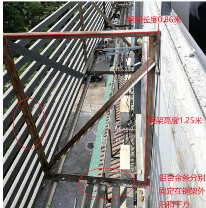
图4-3、水贝茂名大厦409室事发外墙装饰栏杆尺寸及现状图
