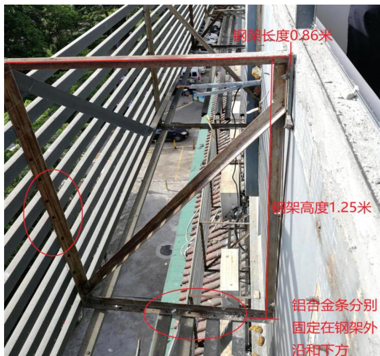
图1-6. 水贝茂名大厦409室事发外墙装饰栏杆尺寸及现状图
