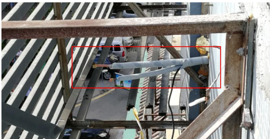
图1-7. 水贝茂名大厦409室事发外墙空调铜管外露情况
