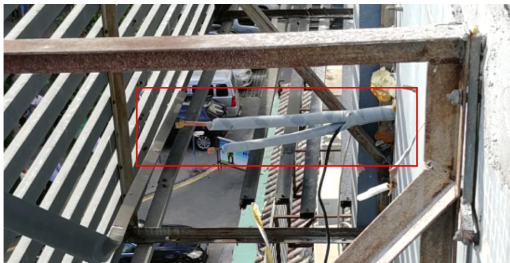
图4-5、水贝茂名大厦409室事发外墙空调铜管外露情况
