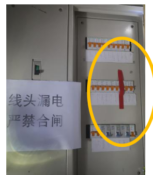
图4-19 店铺总配电箱外观 图4-20 控制裸露线头的开关事故时合闸 图4-21 事故调查后开关分闸
