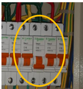
图4-19 店铺总配电箱外观 图4-20 控制裸露线头的开关事故时合闸 图4-21 事故调查后开关分闸
