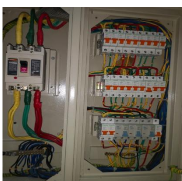
图4-19 店铺总配电箱外观 图4-20 控制裸露线头的开关事故时合闸 图4-21 事故调查后开关分闸
