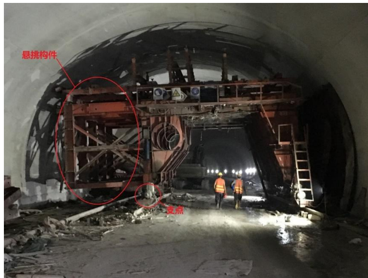
图 13 事发台车中存在的悬挑构件
