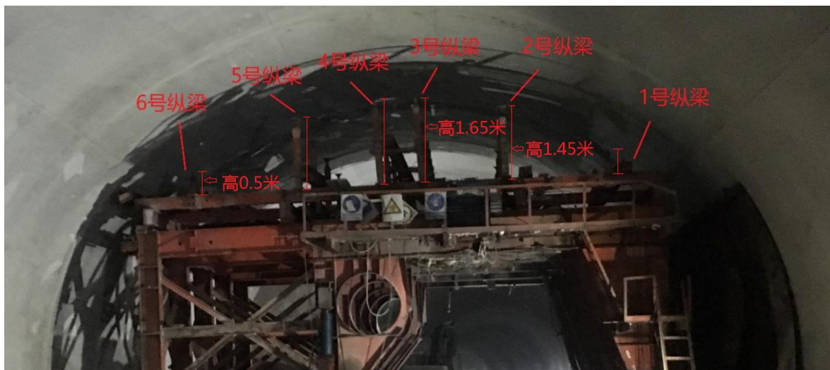
图 7 事发台车各纵梁位置
