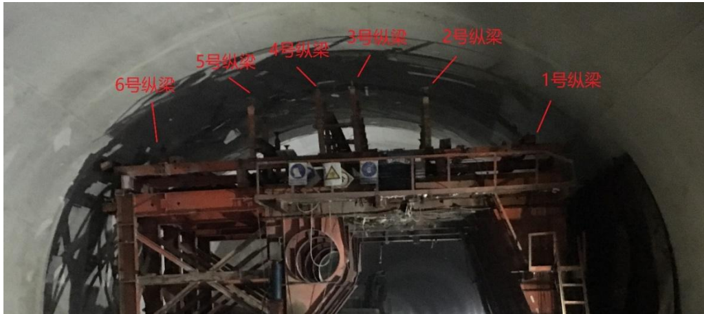
图 2 事发台车各纵梁的位置
