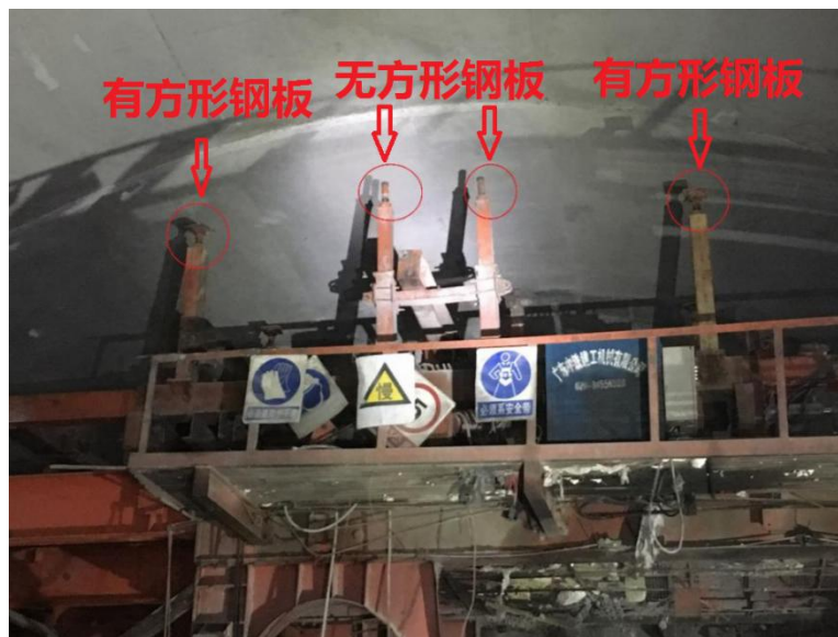
图 9 事发台车立柱方形钢板情况
