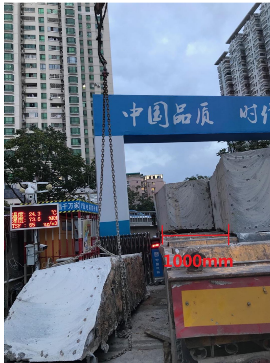
图 14 事发时平板车辆存在混凝土块的情况
