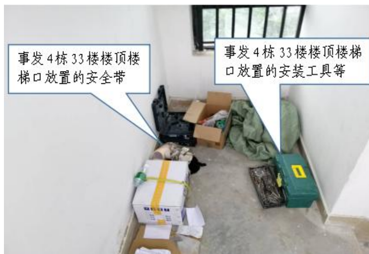
图 10 4 栋 33 楼楼顶楼梯口放置的未使用的安全带和安装雨棚使用的工具
