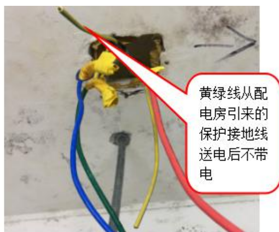
图 11 事发金属人字梯上方天花板电源线分线盒内电源线接线勘查图
