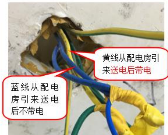
图 8 事发金属人字梯上方天花板电源线分线盒内电源线接线勘查图
