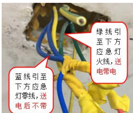
图 10 事发金属人字梯上方天花板电源线分线盒内电源线接线勘查图
