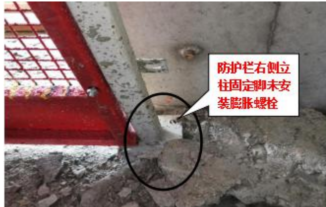
图 24 事发处防护栏恢复位置勘查图
