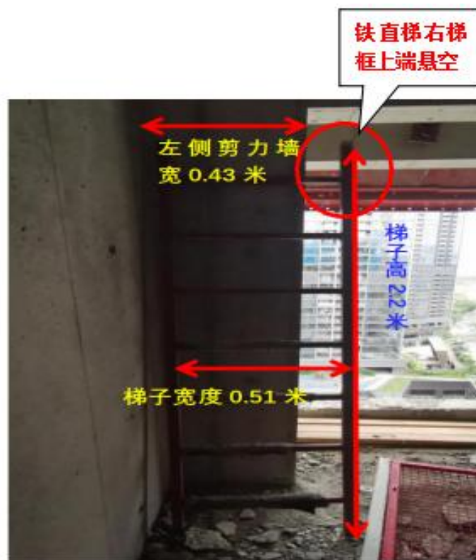
图 28 铁直梯搭设在剪力墙上模拟图
