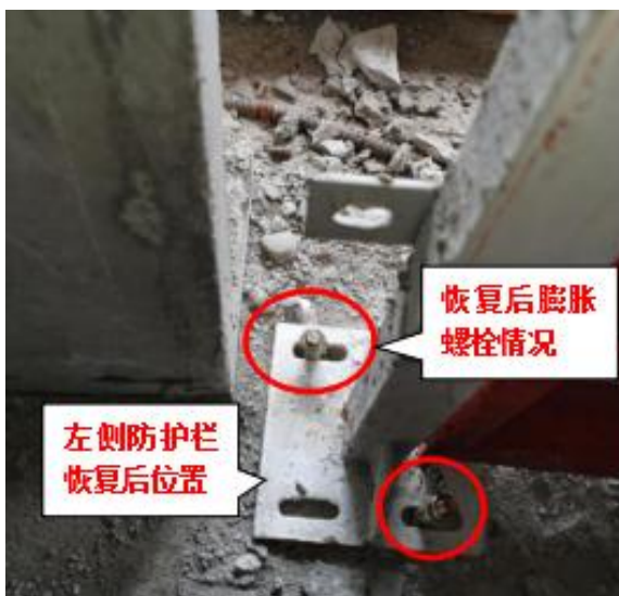
图 23 事发处防护栏恢复位置勘查图 拍摄人：谢君 拍摄时间：2020 年 4 月 2 日 16 时 40 分
