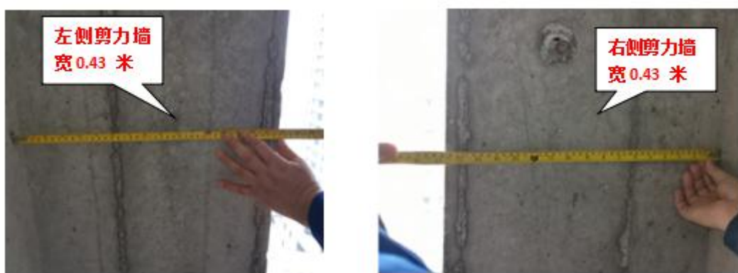
图 13 事发处左右剪力墙勘查图 拍摄人：谢君 拍摄时间：2020 年 4 月 2 日 16 时 25 分
