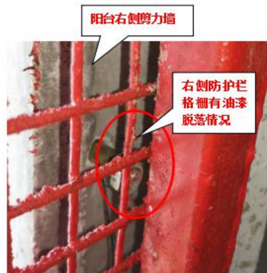
图 22 事发处防护栏安装位置勘查图 拍摄人：谢君 拍摄时间：2020 年 4 月 2 日 16 时 35 分
