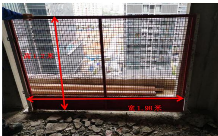
图 10 事发处防护栏勘查图
