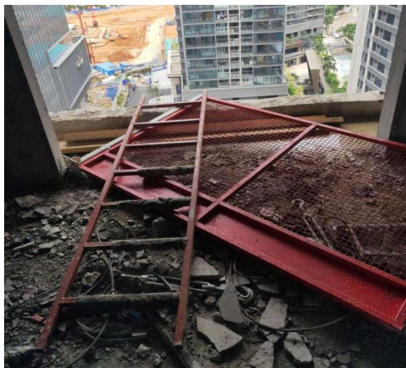
图 6 事发处防护栏、铁直梯位置勘查图 照片提供者：中国华西公司胡家中 提供时间：2020 年 4 月 6 日
