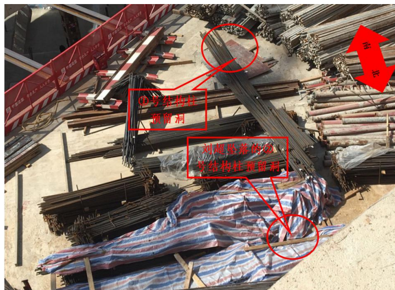
图 8 ①、②号结构柱预留洞及周边事发前状况图
