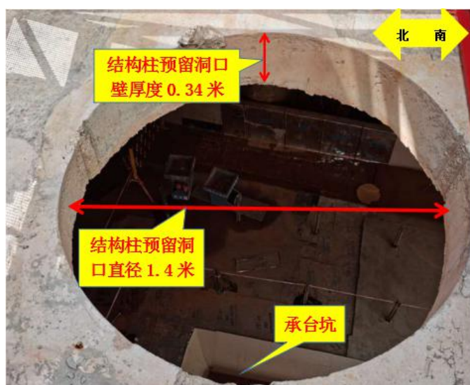
图 11 事发结构柱预留洞口勘查图
