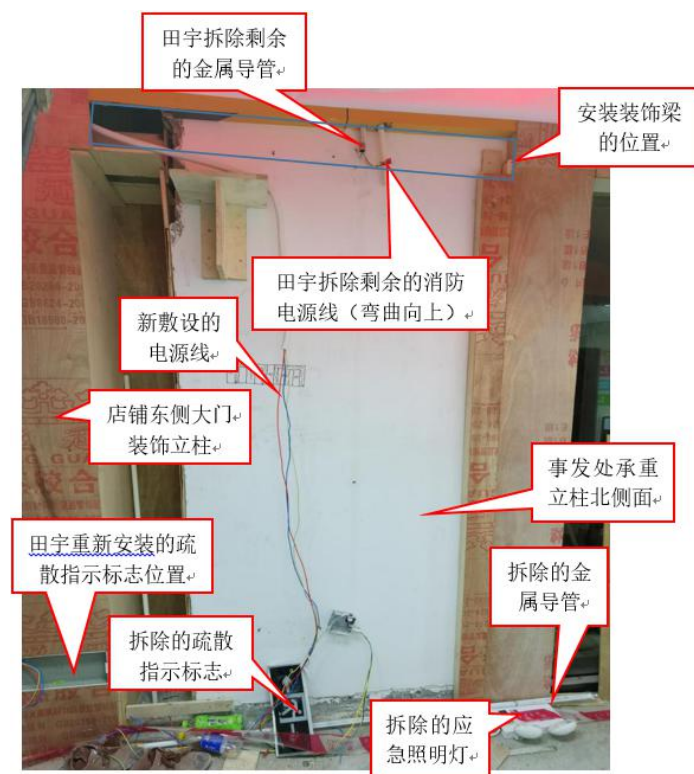
图 3 承重立柱上的应急灯、疏散指示标志灯、消防电源线及金属导管拆除后现状图
