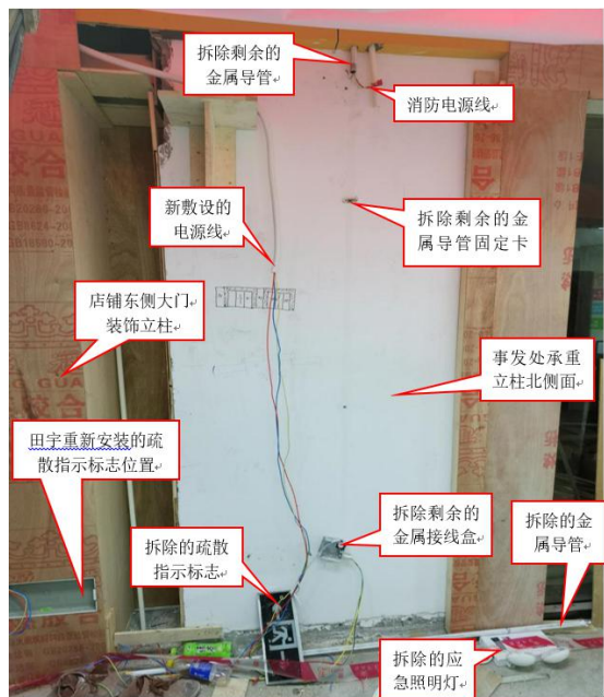
图 6 事发处承重立柱北侧面勘查图
