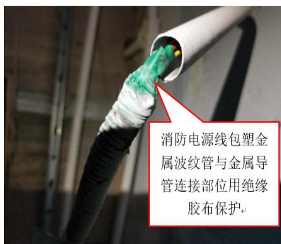
图 18 金属导管与包塑波纹管连接处勘查图
