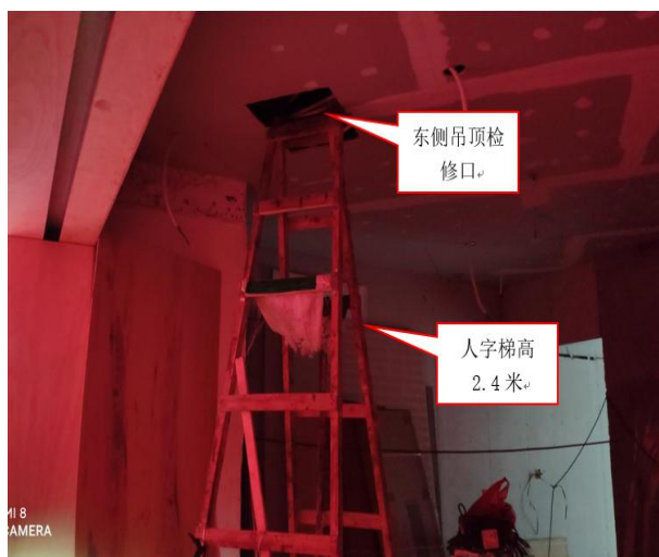
图 20 事发商铺东侧吊顶检修口勘查图
