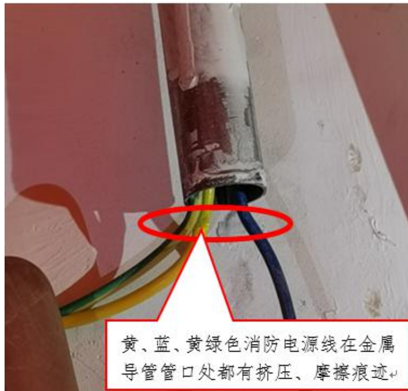
图8 黄色、蓝色、黄绿色三根消防电源线 勘查图
