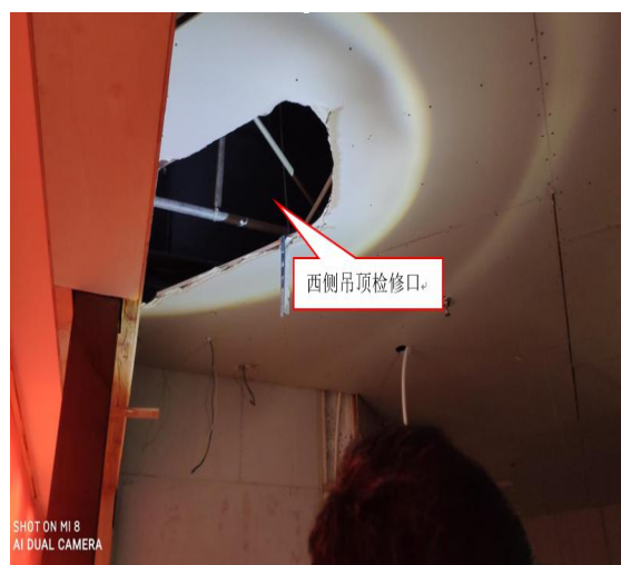
图 21 事发商铺西侧吊顶检修口勘查图
