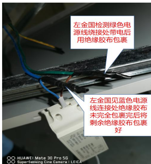
图 8 事发后左金国处理后的 3#照明方片灯恒流驱动电源接线勘查图
