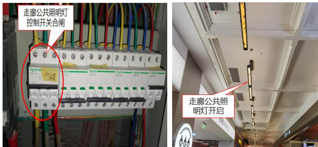
图 23 走廊公共照明灯控制开关合闸时照明灯亮测试勘查图
