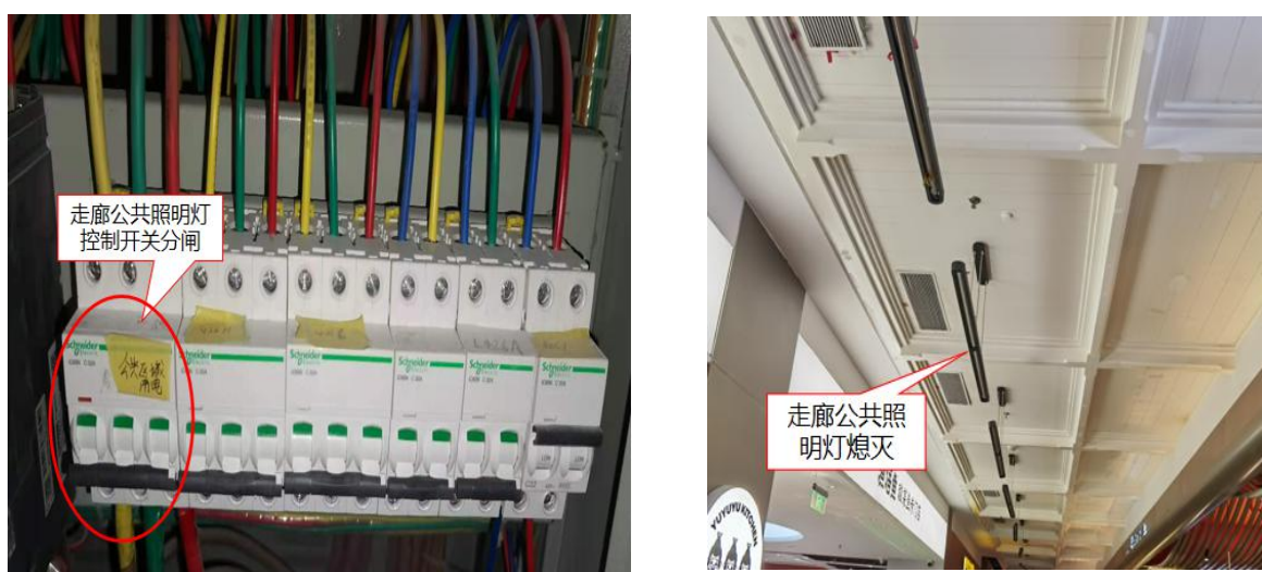
图 24 走廊公共照明灯控制开关分闸时照明灯熄灭测试勘查图
