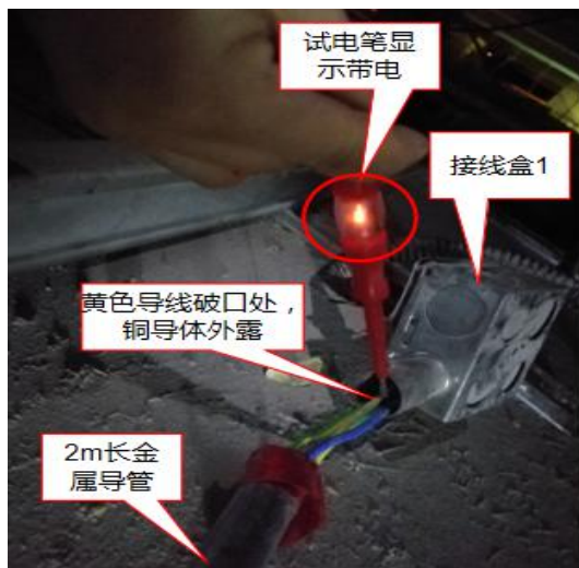
图 29 金属导管内黄色导线绝缘层破损位置 裸露铜导体带电情况检测图 拍摄人：谢君 拍摄时间：2020 年 11 月 18 日
