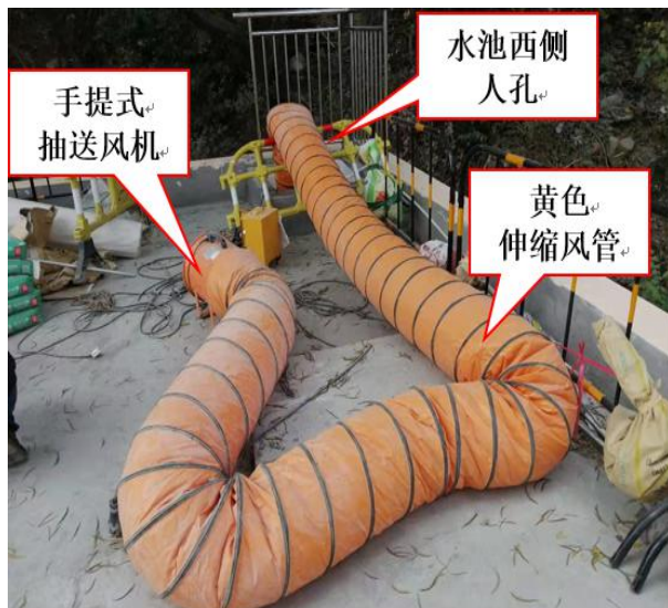
图 13 手提式抽送风机位置勘查图
