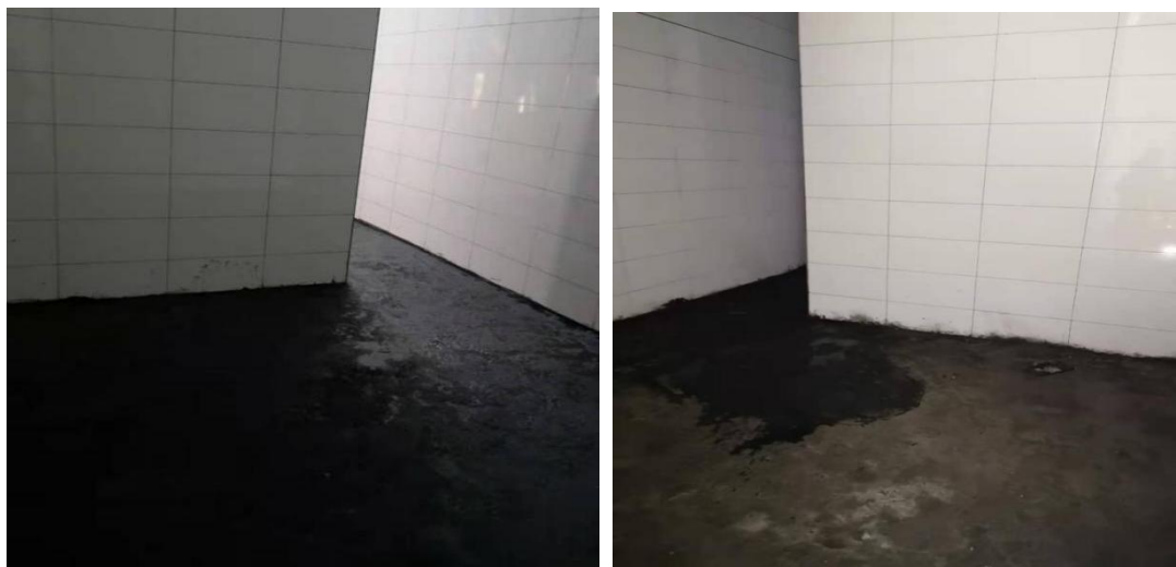
图 5 事发泵房水池西南侧水池底部地面防水涂料涂刷勘查图
