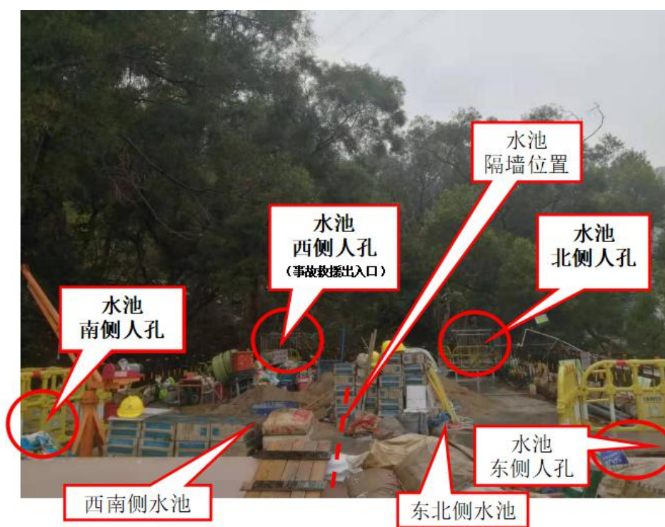
图 4 事发泵房水池顶部平台勘查图
