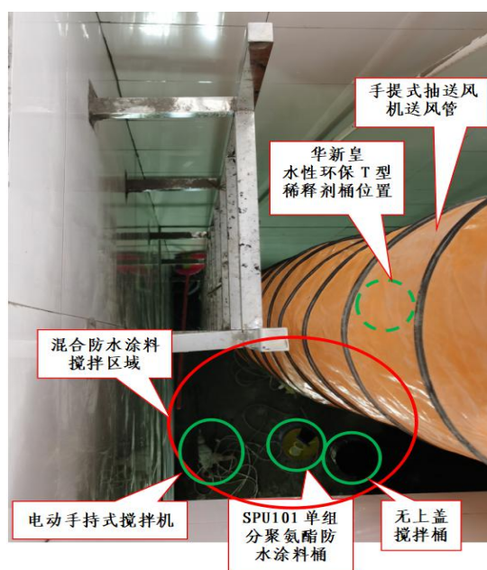
图 8 事发泵房水池西侧人孔勘查图
