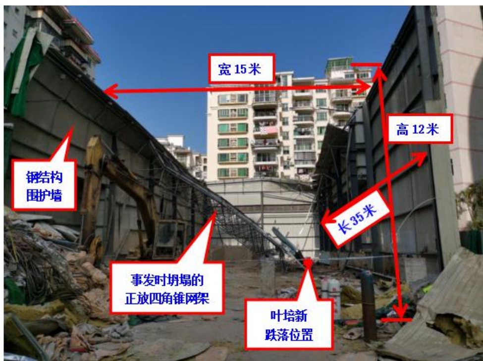
图 4 事发钢筋加工棚坍塌后勘查图
