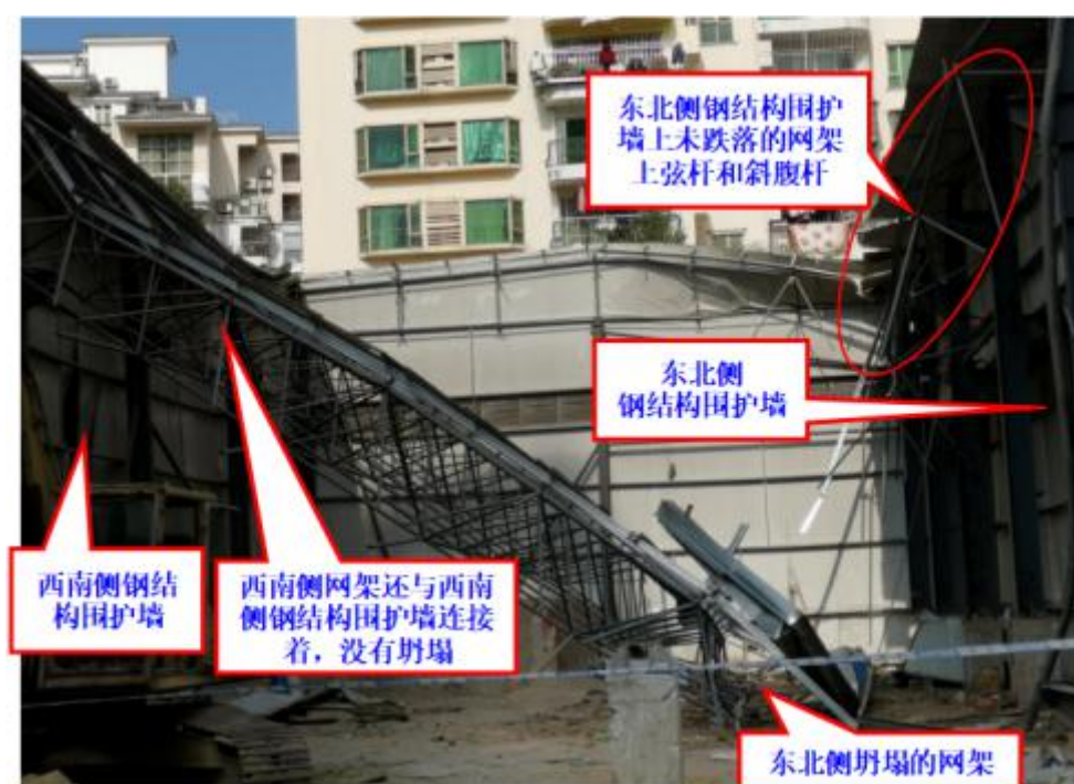
图7 事发钢筋加工棚顶棚正放四角锥网架坍塌勘查图
