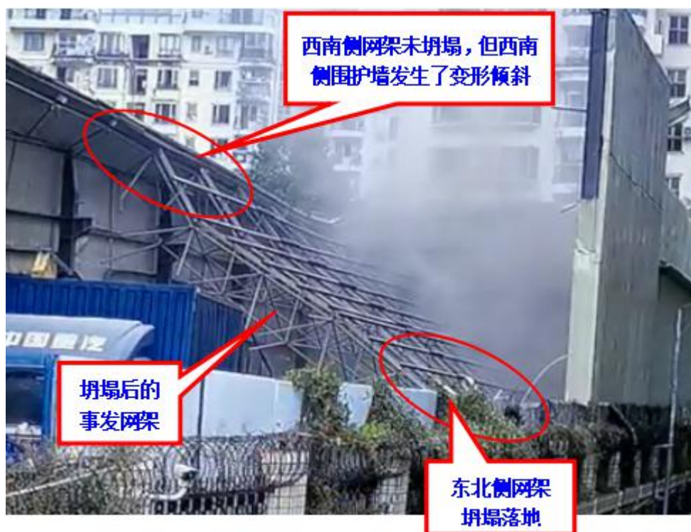
图3 事发钢筋加工棚正放四角锥网架坍塌过程监控视频截图 视频时间：2021年1月24日
