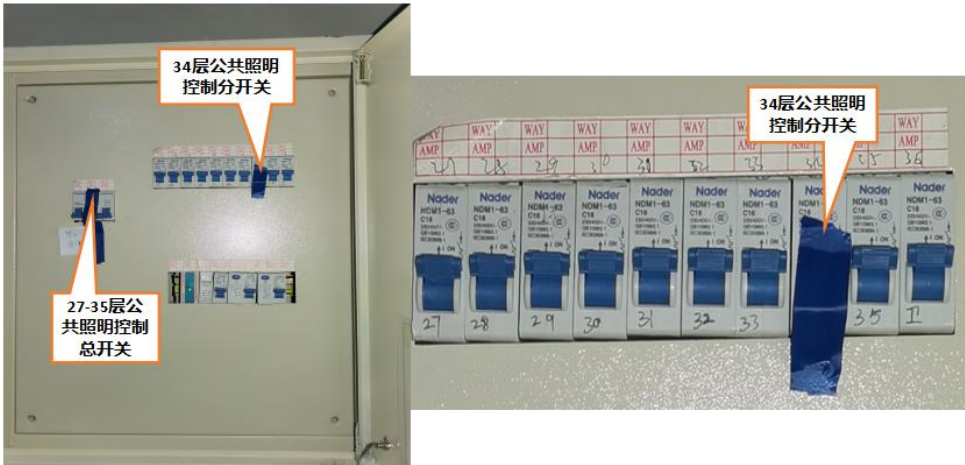
图 11 万科深南广场 T1 座 31 层低压配电室内公共照明控制电箱勘查图
