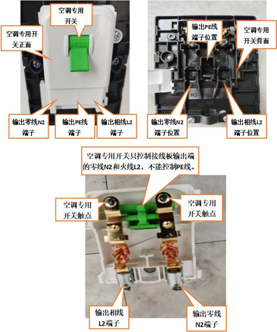
图 10 空调专用开关电源输出端勘查图
