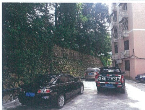
照片 1 挡墙概况
